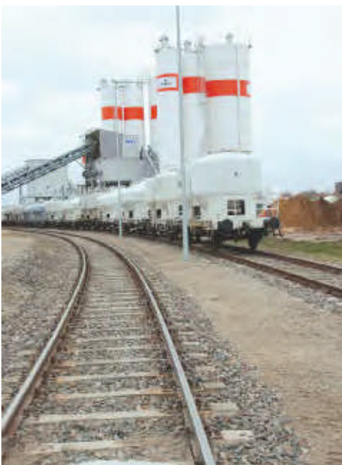
Anschlussbahn zum Zentralen Betonmischwerk zum Großflughafen BBI
